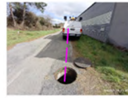
Foto 06. Traslado desde la arqueta hacia el punto de perforación.
