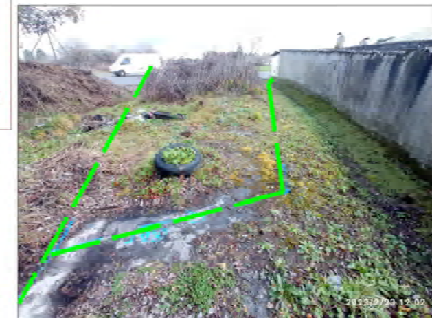
Foto 05. Ramal acometida a vivienda
