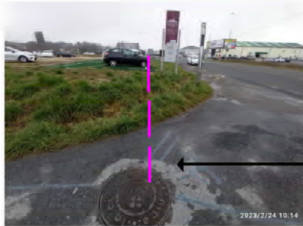
Foto 01. Cámara registro nº 263 de la que parte prisma 6TØ110 afectado por colector. Profundidad aprox. 1,40 m.
