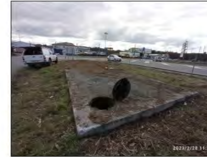
Foto 03. Arquea ACUAES, no se puede tomar profundidad, interior lleno de agua. Vendrá reflejado en plano facilitado por ACUAES
