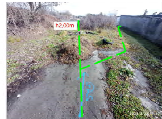
Foto 06. Recorrido canalización general y salida ramal
