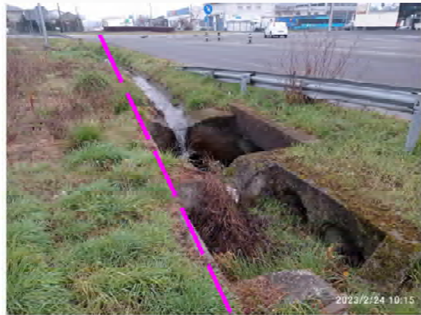
Foto 03. Obras de fábrica cruce calzada c/Adolfo Suárez
