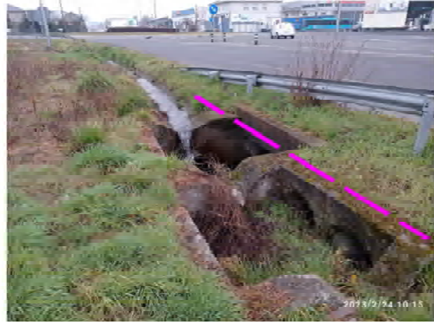
Foto 01. Obra de fábrica cruce cañada c/Adolfo Suárez
