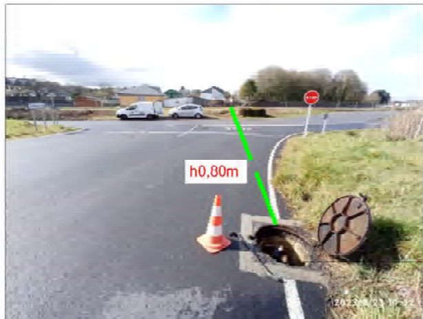
Foto 03. Recorrido desde la arqueta (ubicada en arcén crta. hacia Portela y As Regas, alberga válvula corte) hacia cruce Ronda Norte. A la altura del STOP va envainada y pasa de una profundidad de 0,80 a 1,50 m.
