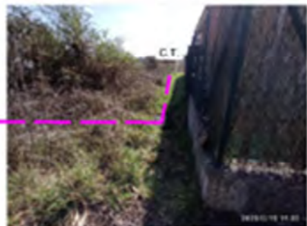
Foto 07. Traslado desde el punto de perforación hacia la arqueta.
