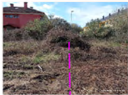
Foto 02. Traslado desde la arqueta hacia la ubicación final de la línea de saneamiento.
