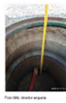
Foto 04b. Mirada desde el interior de la arqueta hacia el interior del tubo de PVC.
