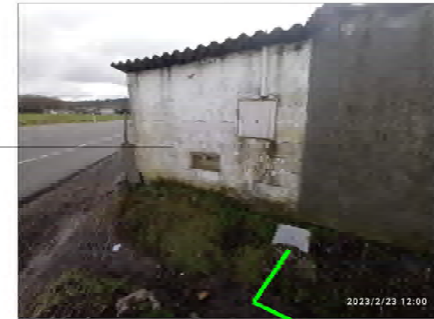
Foto 04. Esquina alpendre pegado a Ronda Norte donde entra acometida a vivienda
