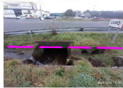
Foto D1a Vista frontal obra de fábrica
