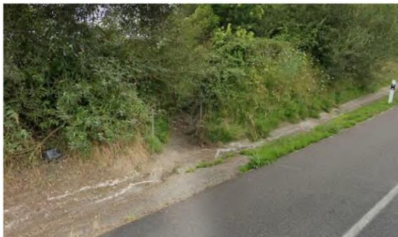
Desagüe de la balsa a través del colector bajo cuneta existente en la ronda norte.
