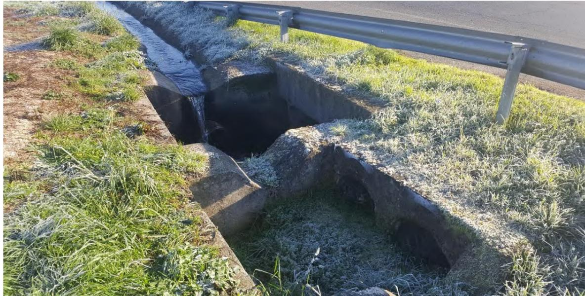
A partir de este punto los caudales discurren a cielo abierto entre una nave industrial y una zona adyacente de aparcamiento hasta alcanzar el cauce del Fervedoira. Existe un marco de hormigón armado que conecta la nave con la parcela adyacente.
