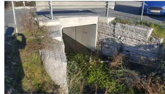
Marco de hormigón armado de 2x2 situado en cauce existente en aparcamiento de nave comercial.
