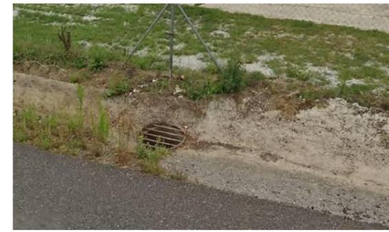
Colector de pluviales existente bajo la cuneta de la ronda norte.
