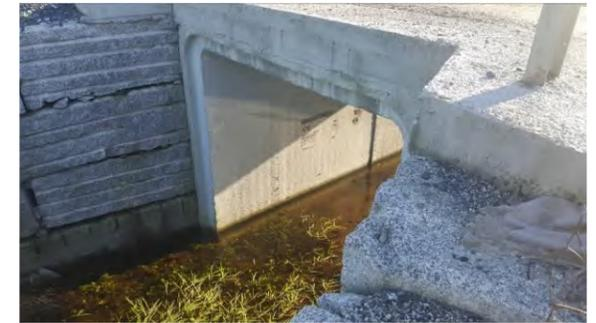
Marco de hormigón armado de 2x2 situado en cauce existente en aparcamiento de nave comercial.
