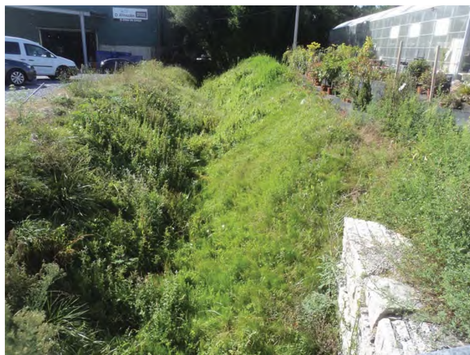
Fotografía 8: Vista de la parte final de los colectores. Zona Falcón Agroalimentaria.
