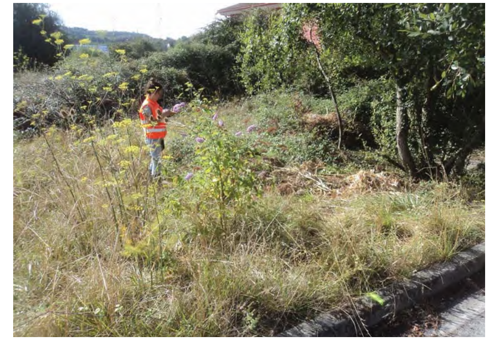
Fotografía 5: Zona de salida del pozo de hinca.
