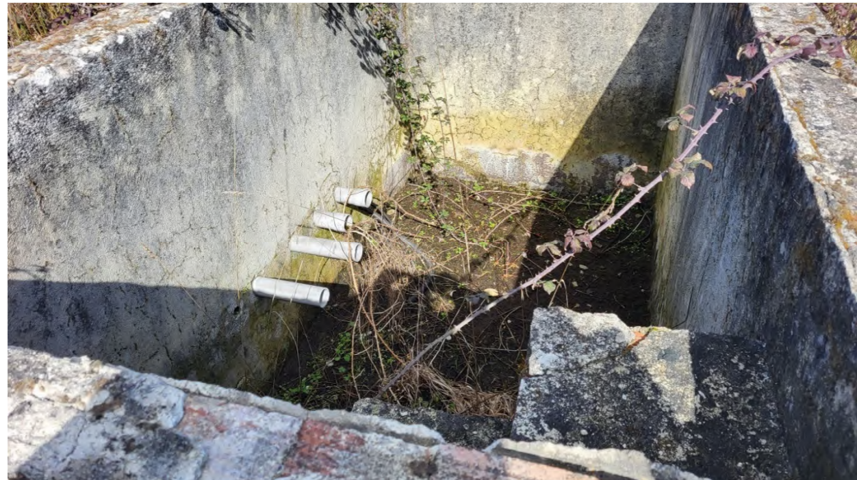
Foto 10b. Interior arqueta
