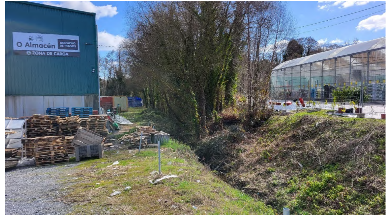
Foto 21. Continúa cauce natural entre OF Almacenes Falcón y río Fervedoira
