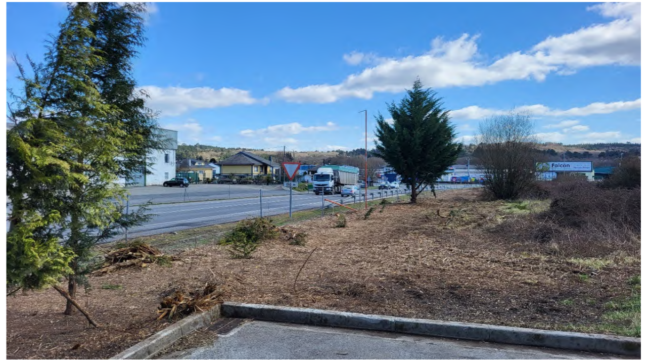
Foto 06a. Ubicación pozos salida
