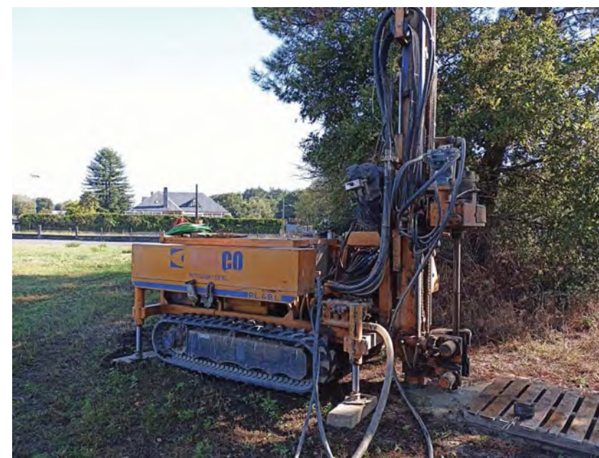
Fotografía 9: Emplazamiento sondeo S-1
