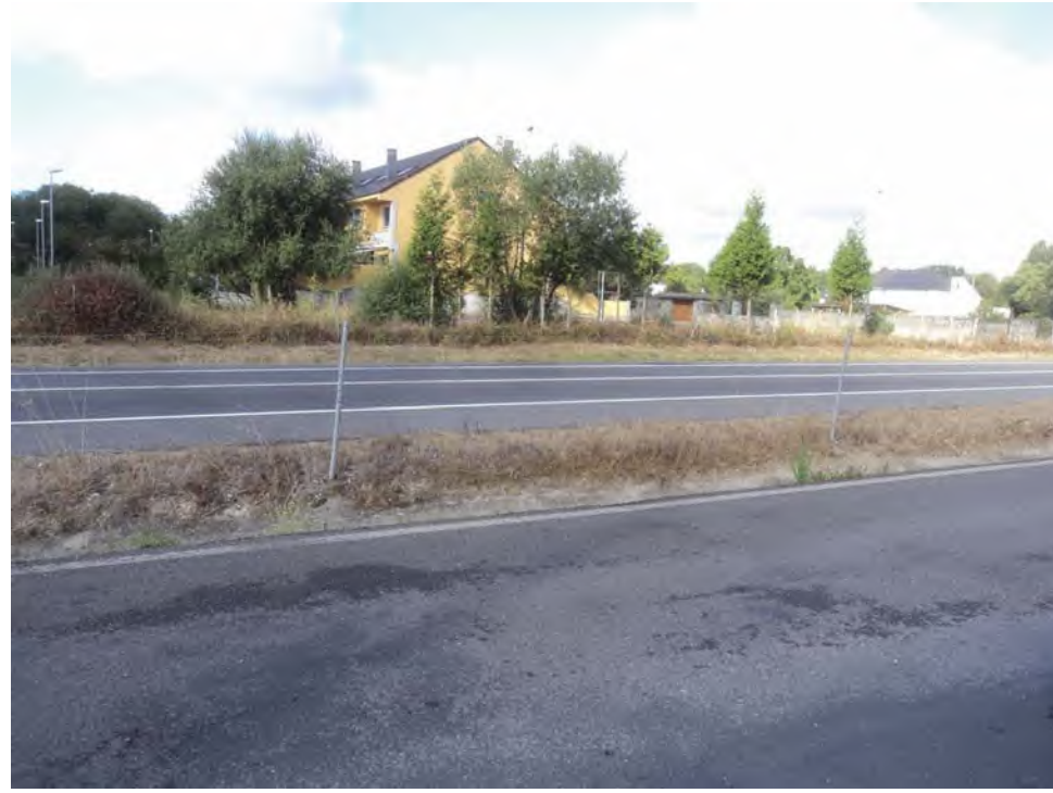
Fotografía 4: Vista de Ronda Norte donde se realizará la hinca subterránea.
