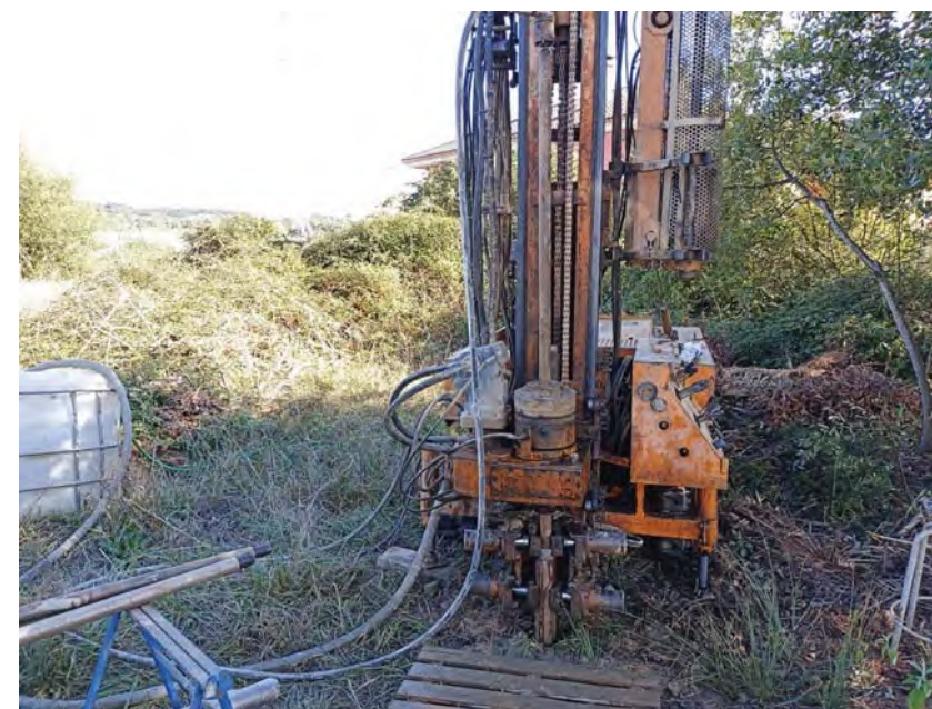
Fotografía 10: Emplazamiento sondeo S-2
