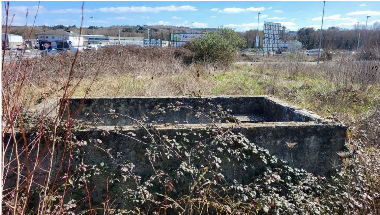
Foto 10a. Arqueta próxima a piscina
