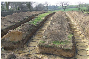
Colocación de captación superficial.
