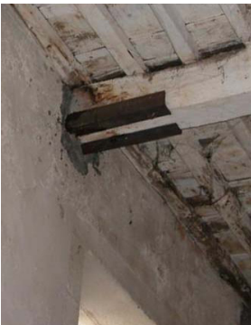
Reparación de cabeza de vigas o viguetas con angulares de acero.
