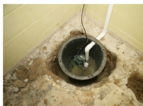
Toda el agua recogida en una canaleta debe ser conducida a un pozo de bombeo para su evacuación hasta la red de saneamiento.
