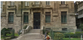
Edificio público (BE) que aprovechó su jardín para crear una rampa exterior para personas discapacitadas.
