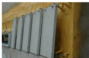
Construcción de fachada ventilada pétreo.
