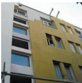
Colocación de aislamiento térmico en una rehabilitación con sistema SATE.
