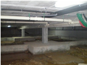
Forjado unidireccional como suelo elevado, sobre terreno estacionalmente encharcable.
