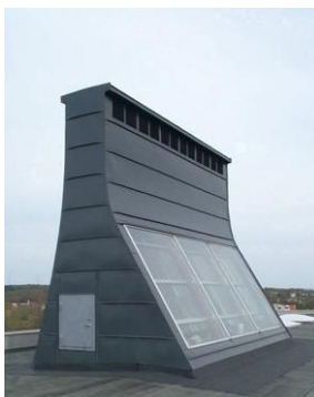
Chimenea solar con efecto invernadero.
