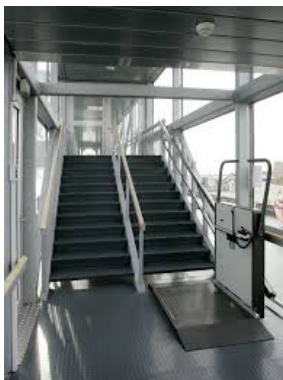
El salvaescaleras resuelve un desnivel para discapacitados con menos espacio que una rampa.
