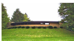
Casa Jacobs II, F. Lloyd Wright. Aprovechamiento de la alta inercia térmica de los muros de piedra semienterrados como acumuladores de la energía captada a través de la fachada Sur.
