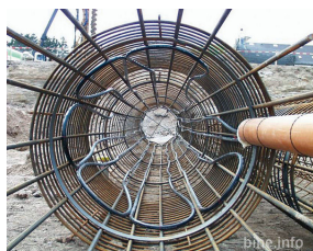
Colocación de tubos para captación en pozo.
