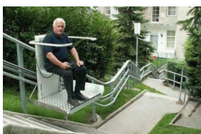
Modelo de salvaescaleras para la accesibilidad en un fuerte desnivel de una urbanización.
