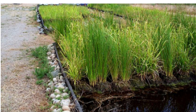
Macrofitas para la depuración de aguas grises.
