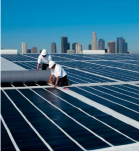
Instalación de membrana fotovoltaica en cubierta.
