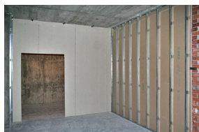
Ejecución de trasdosado interior.
