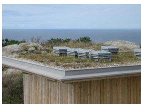
Cubierta ajardinada integrada con el entorno.
