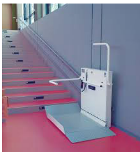
Modelo de salvaescaleras para acceso con trayectoria paralela a la escalera.
