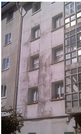
Fachada de muro de carga protegida con tabique pluvial.
