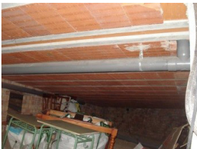
Forjado unidireccional como suelo elevado, con acceso para mantenimiento de instalaciones suspendidas.
