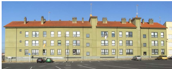
Estado do edificio antes da actuación
