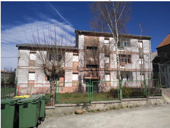
Estado do edificio antes da actuación
