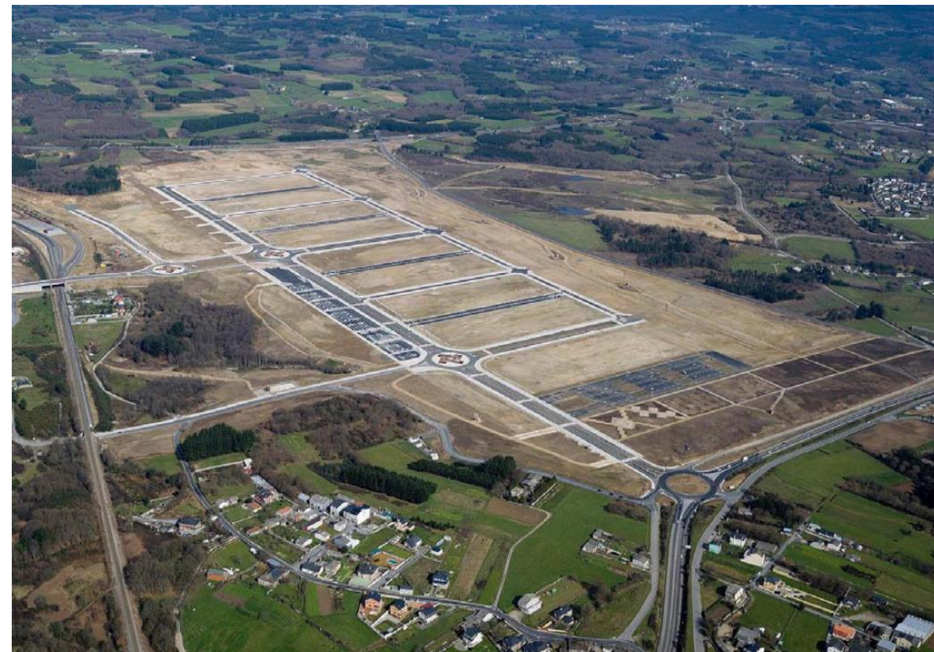
Imagen Nº 1: Imagen aérea de la ejecución de la Fase I del Parque Empresarial de As Gándaras (Lugo) – Año 2011
