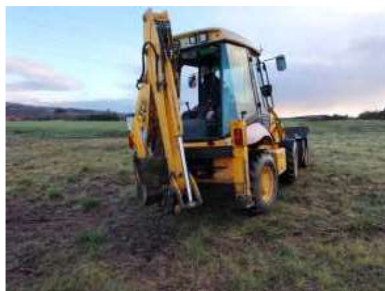
Figura 3. Máquina JCB 3CX empleada para la ejecución de las calicatas (C-1)
