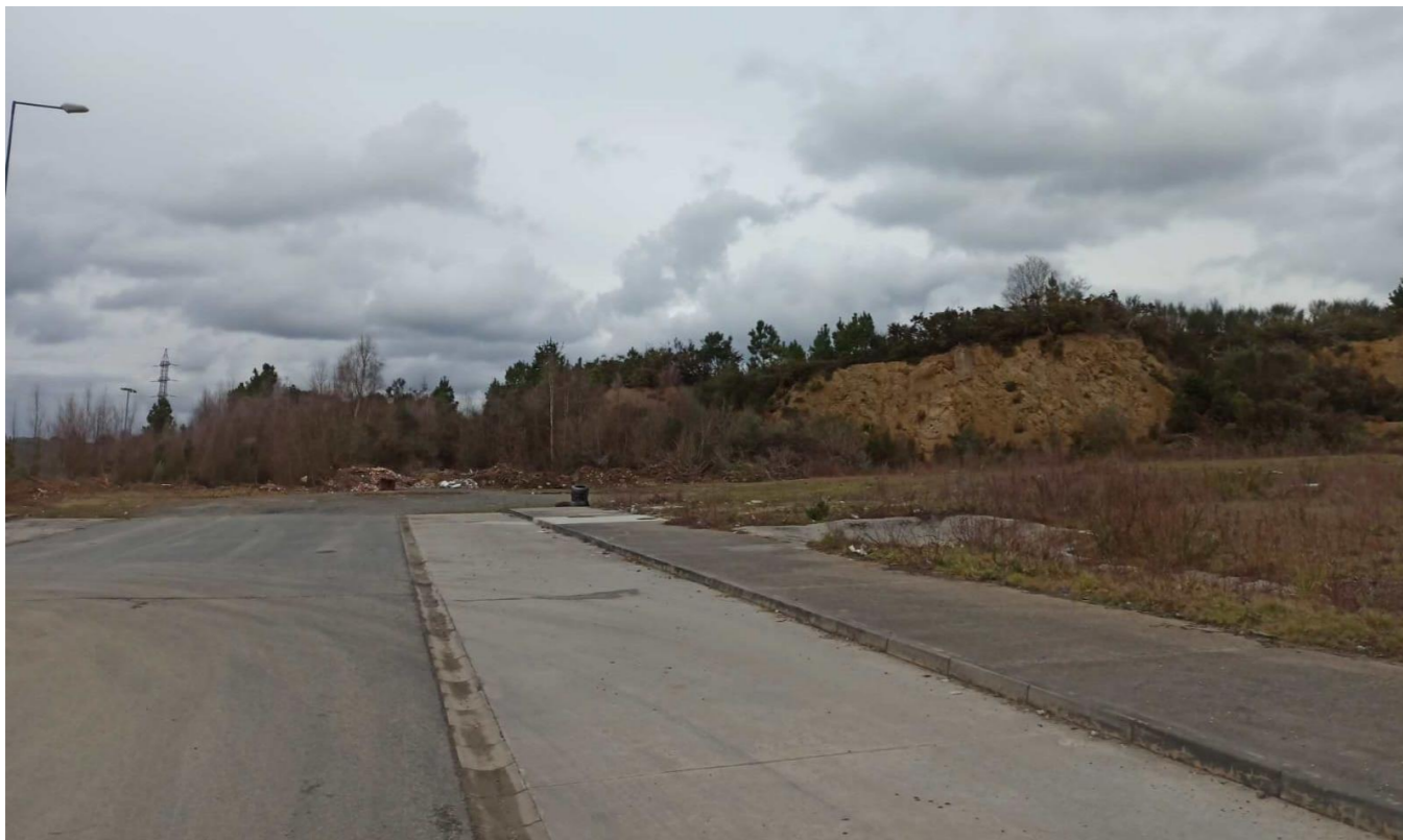
Fotografía 9: Vista sur del ámbito de la Fase VIIa desde final de la Calle J ejecutada
