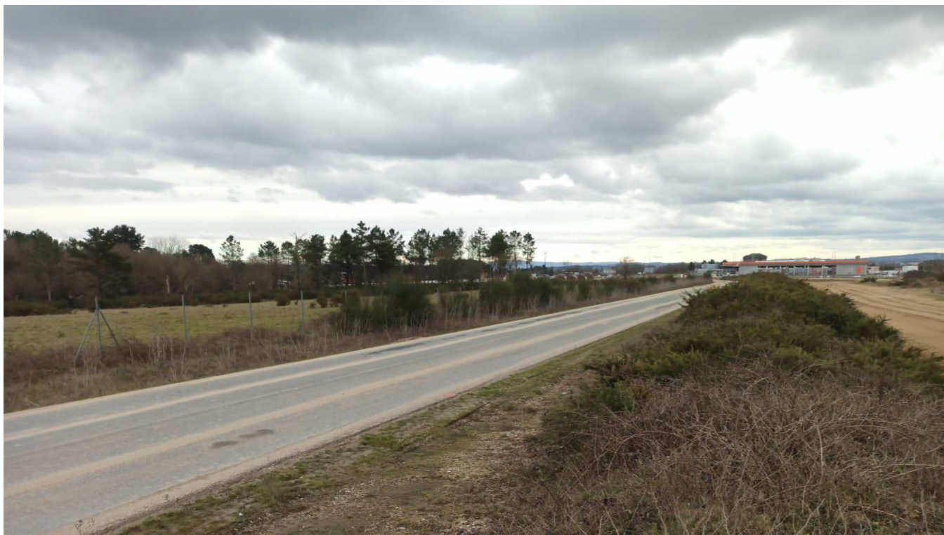
Fotografía 5: Vista norte del vial existente en Fases IV y V
