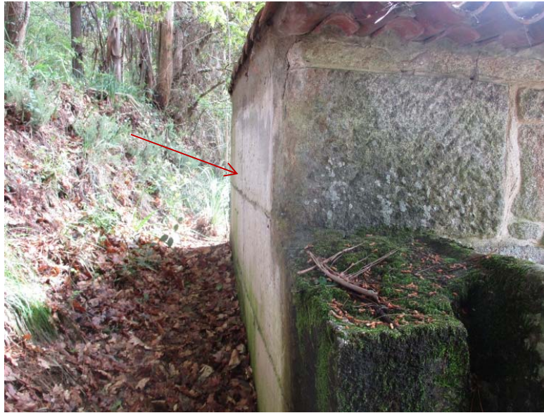
Vista do alzado leste (posterior) realizado en formigón.
