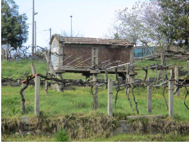
Vista desde o sur. Pode apreciarse o emprego dunha celosía de ladrillo na cámara.
