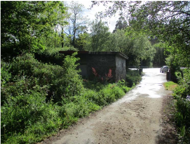
Vista do alzado leste. Pode apreciarse a prolongación da lousa da cuberta á maneira dunha marquesiña sobre o acceso.
