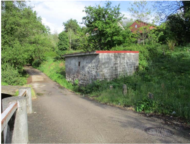
Vista desde o oeste. Pode apreciarse como o muro oeste do muíño está edificado con bloques de formigón.
