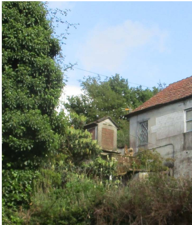
Pode apreciarse como a súa estrutura é de formigón.
