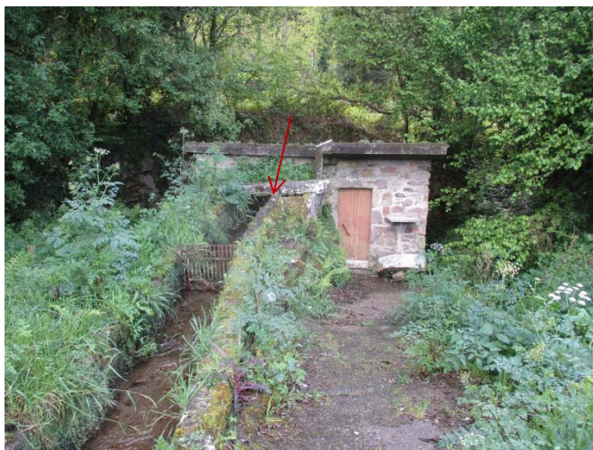
Vista da canle de abastecemento antes de desaugar no cubo (sinalado cunha frecha).
