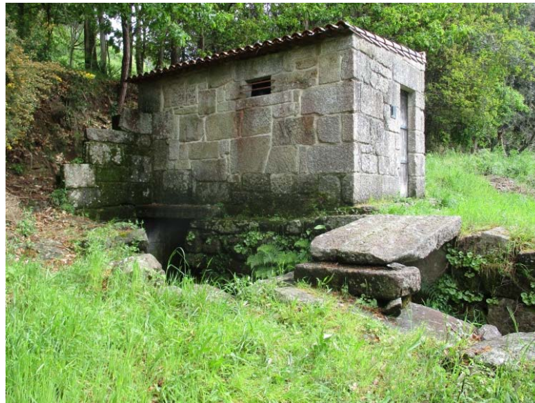
Vista do alzado norte. Pode apreciarse á esquerda da fotografía a pontelle asociada aos muíños.
