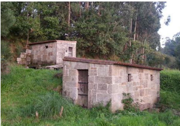
Muíños hidráulicos 02-0206 e 02-207
