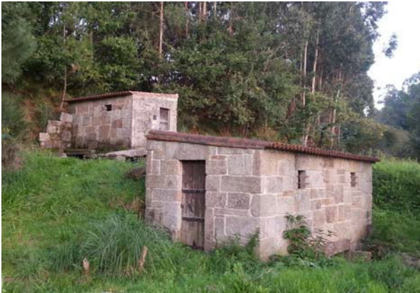
Muíños hidráulicos 02-0206 e 02-207
