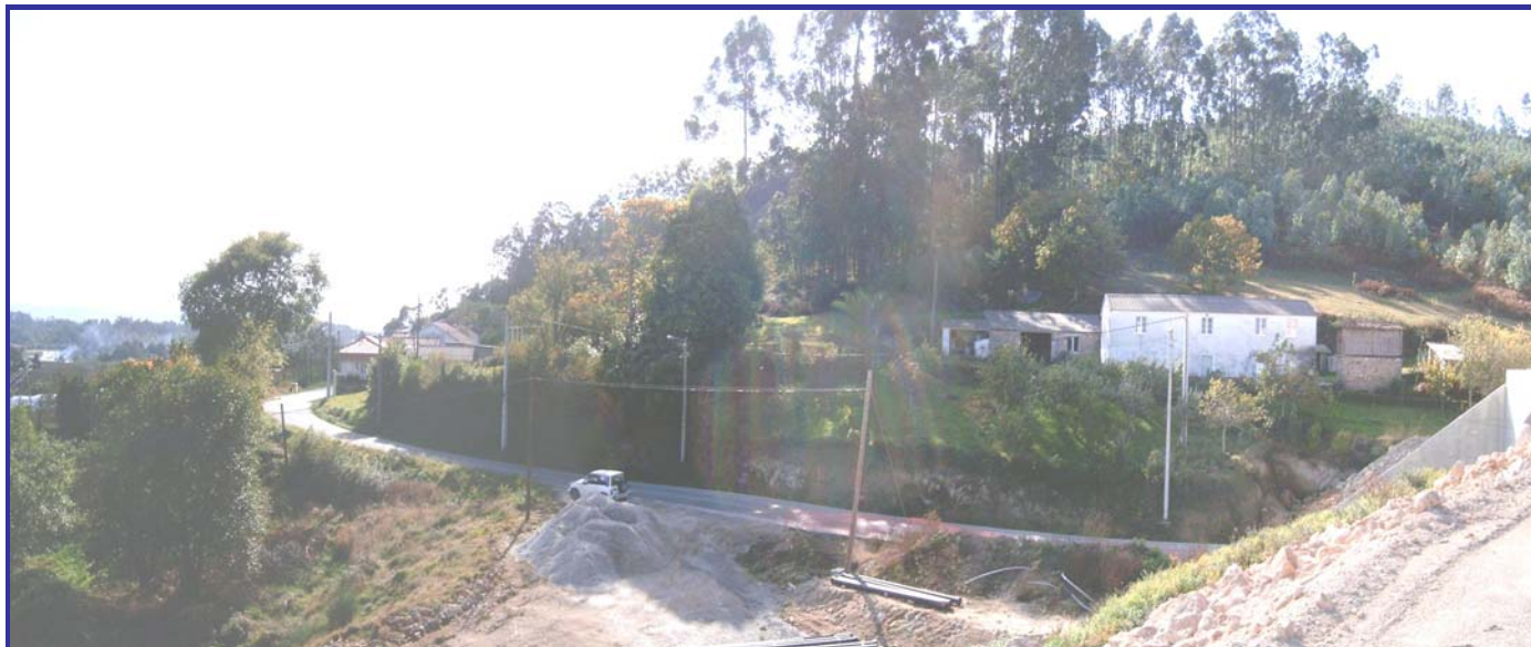
Vista panorámica del Castro de Vilela GA15036004 desde las obras de la autovía al NE. La parcela tiene sus límites en este sector unos 20 m más atrás de este punto.
