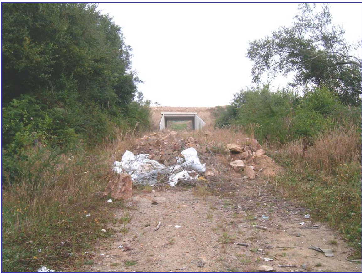
Vista general desde el W de una de las múltiples pistas parcelarias que cruzan toda la zona del parque empresarial y que en muchos casos, como este, se hallan truncadas por la autovía (al fondo de la imagen) que partirá en dos el parque.
