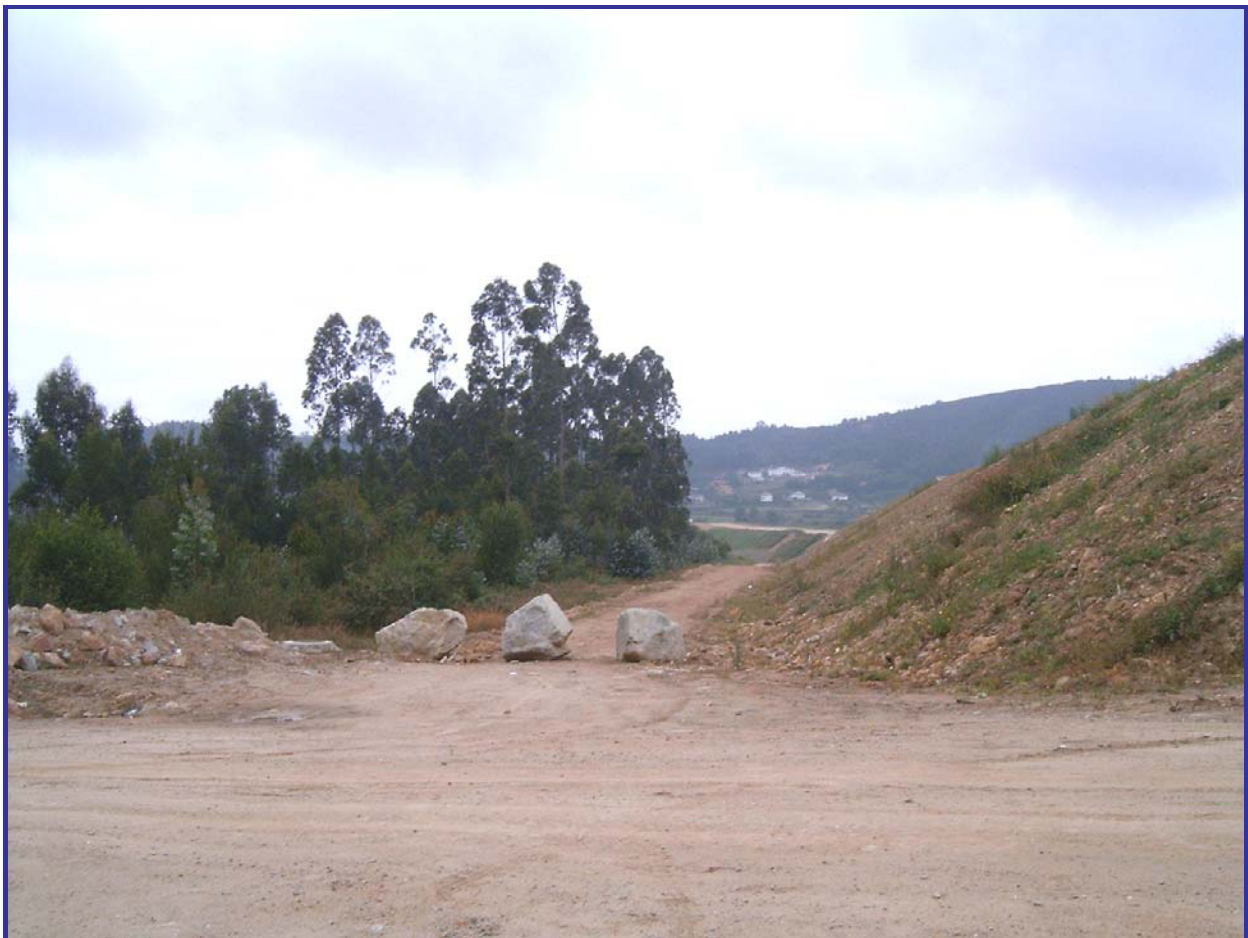
Vista general hacia el NW de la autovía en construcción en medio del futuro parque empresarial desde la finca de As Regueiras.
