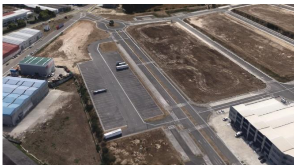
Estado de la obra ejecutada
