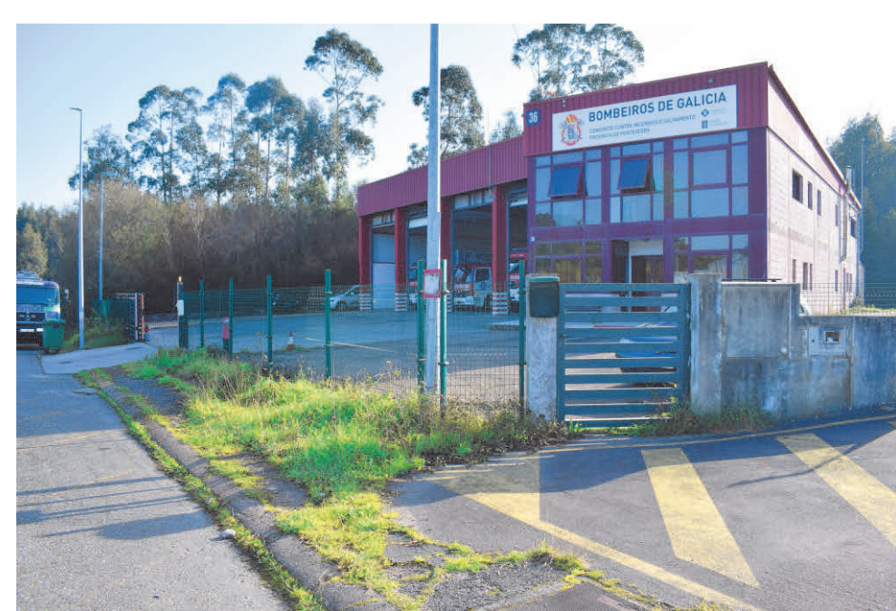
Vista do EP desde o Punto 9. Estación de Bomberos
