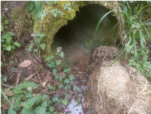
Obra de drenaje bajo pista de tierra en centro-oeste del ámbito
