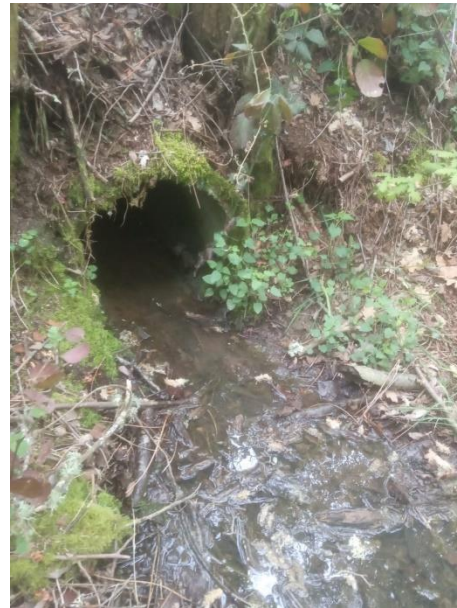
Obra de drenaje bajo pista de tierra en centro-oeste del ámbito
