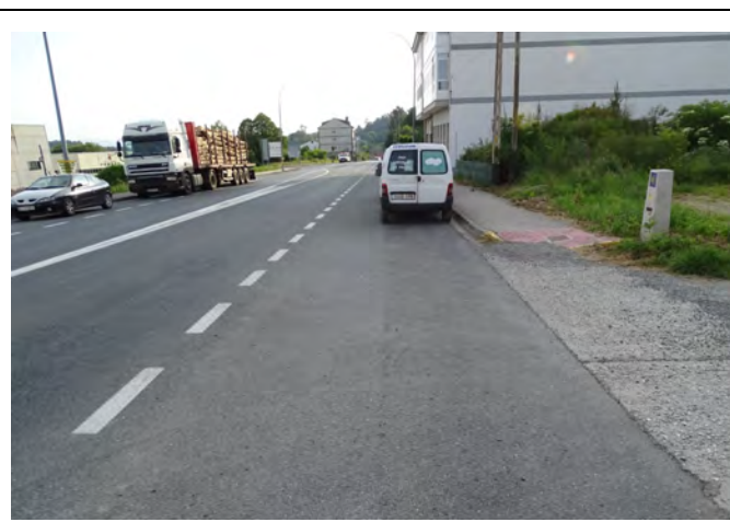
C.11: Indicador de distancia na marxe dereita da N547, fronte ó P.E. Vista dende L
