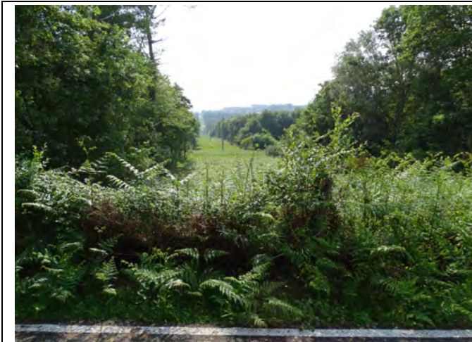
Tendido eléctrico que cruza o terzo S da área de prospección, visto dende L
