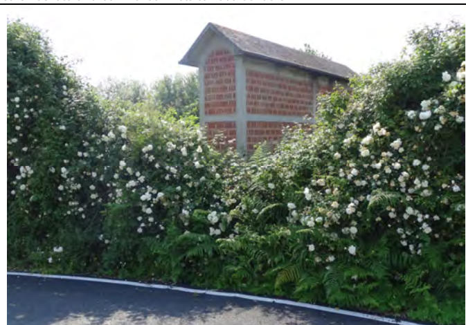
Hórreo 3: construción totalmente actual en formigón e ladrillo localizada nas inmediacións setentrionais da Casa de Rouco. Vista dende L
