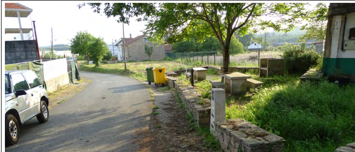
C.8: Indicador de distancia e área de descanso na marxe dereita do Camiño, con edificacións que empezan a amosar caracteres urbanos (edificio á esquerda da imaxe). A vista está tomada dende N
