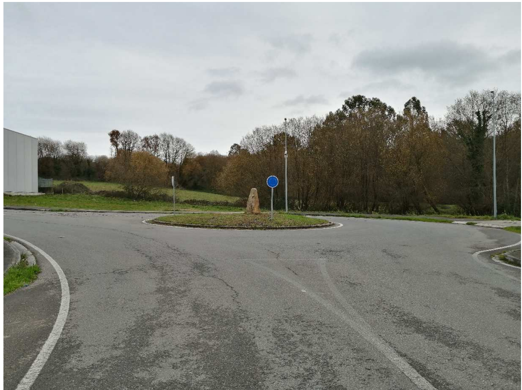
Ilustración 1: Vista da rotonda na dirección na que se proxecta o novo vial
