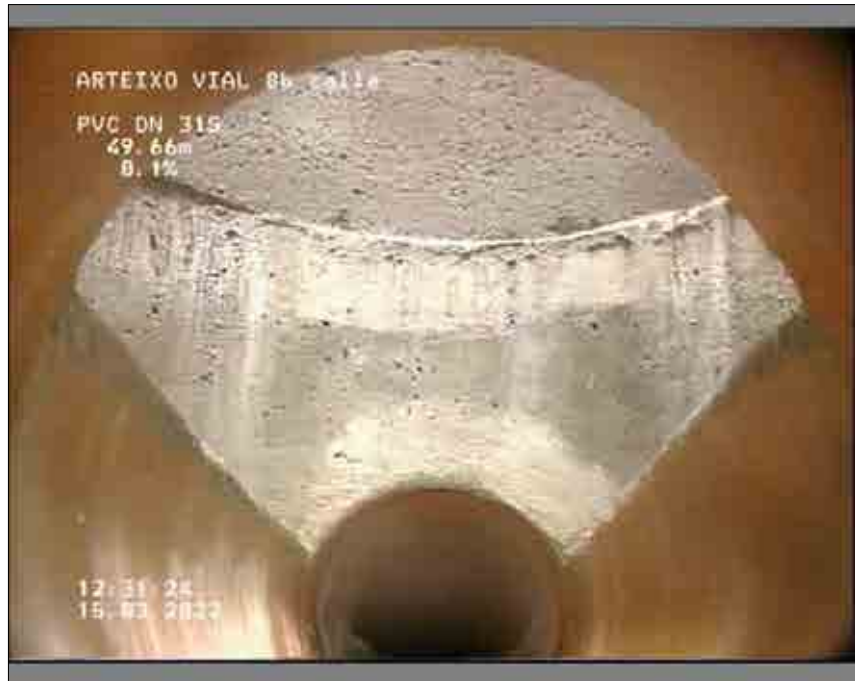
Foto: 8_8_33_A.JPG 49,66m, Fin de la inspección P3
