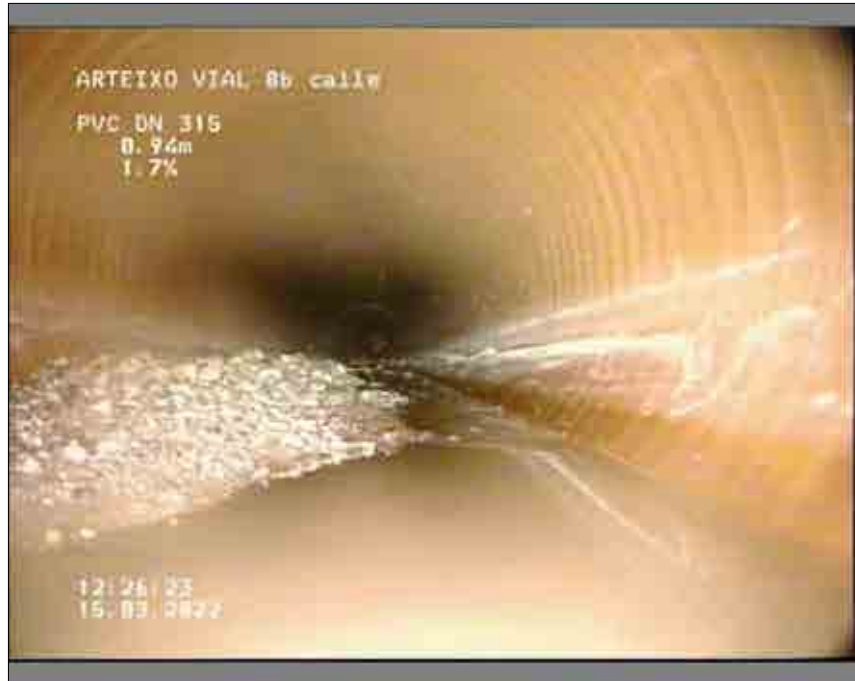
Foto: 8_8_32_A.JPG 0,94m, Obstáculo por sedimentaciones desde 05 hasta 08 horas.
