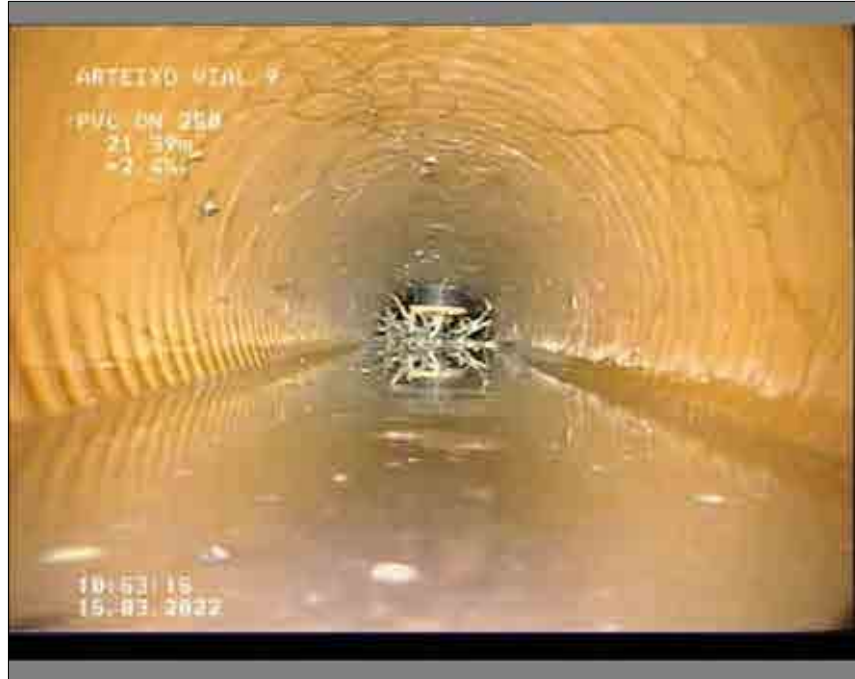
Foto: 2_2_5_A.JPG 21,39m, Retención de agua
