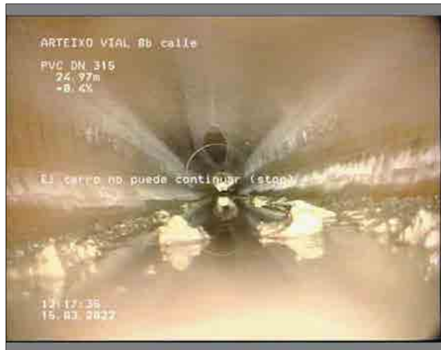
Foto: 7_7_29_A.JPG 24,97m, El carro no puede continuar (stop)
