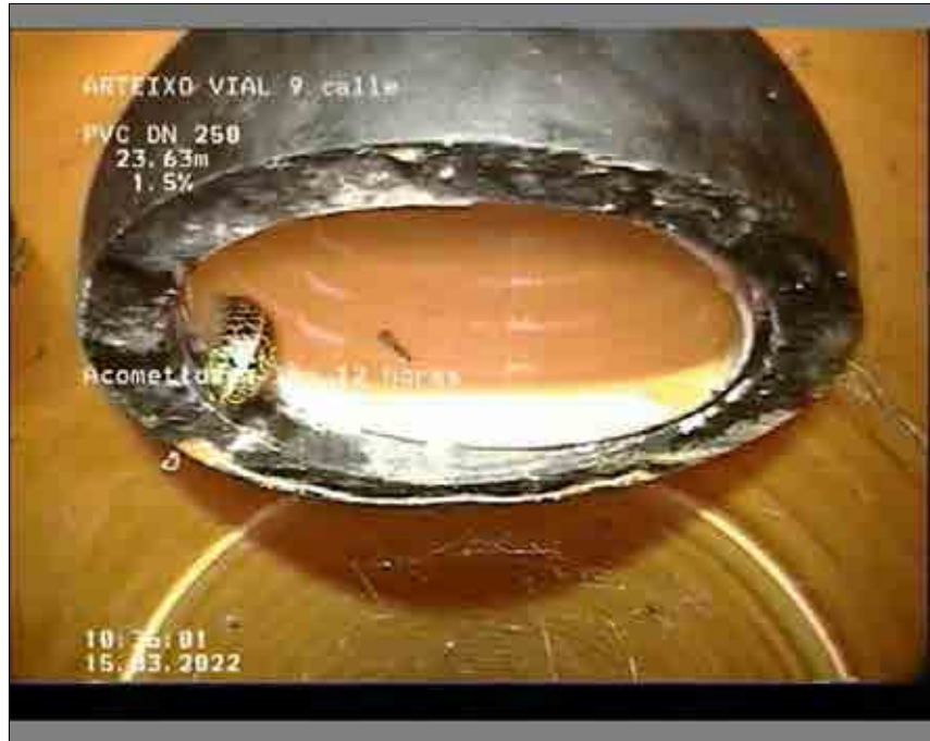
Foto: 1_1_2_A.JPG 23,63m, Acometida a las 12 horas
