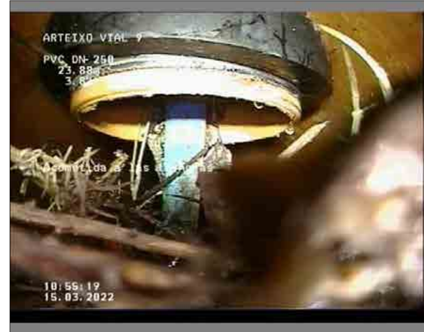
Foto: 2_2_7_A.JPG 23,88m, Acometida a las 12 horas
