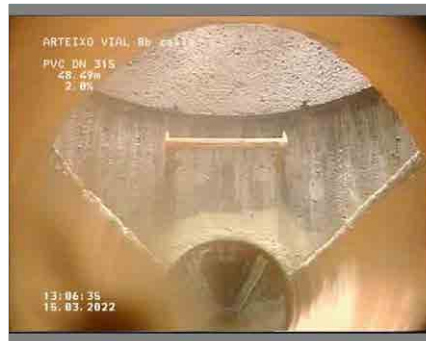
Foto: 10_10_41_A.JPG 48,49m, Fin de la inspección P4
