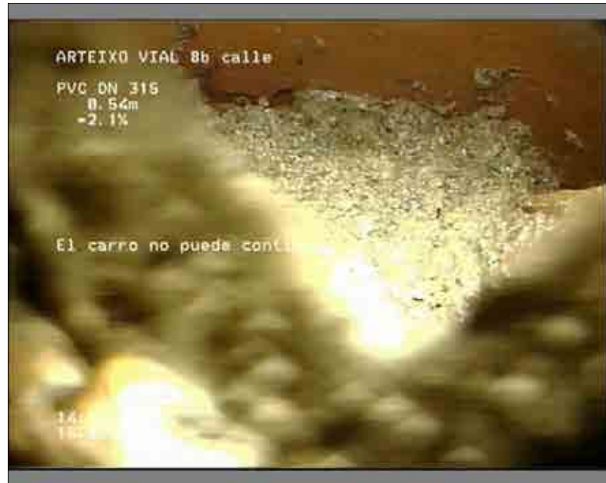
Foto: 14_14_53_A.JPG 0,54m, El carro no puede continuar (stop)
