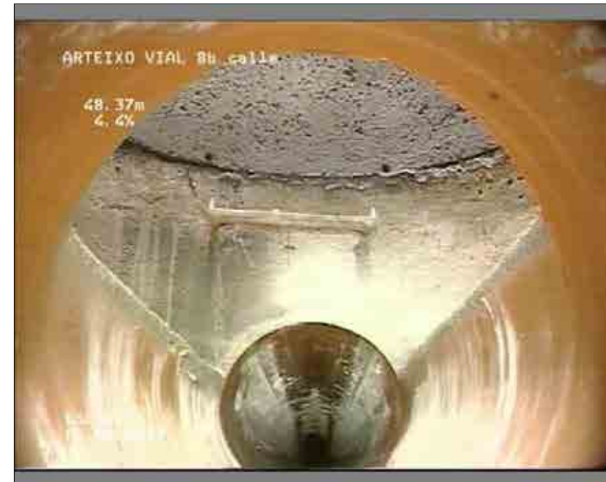
Foto: 12_12_45_A.JPG 48,37m, Fin de la inspección P5
