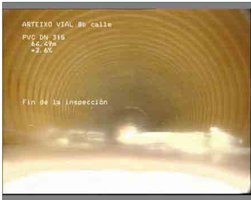
Foto: 13_13_49_A.JPG 64,49m, El carro no puede continuar (stop)
