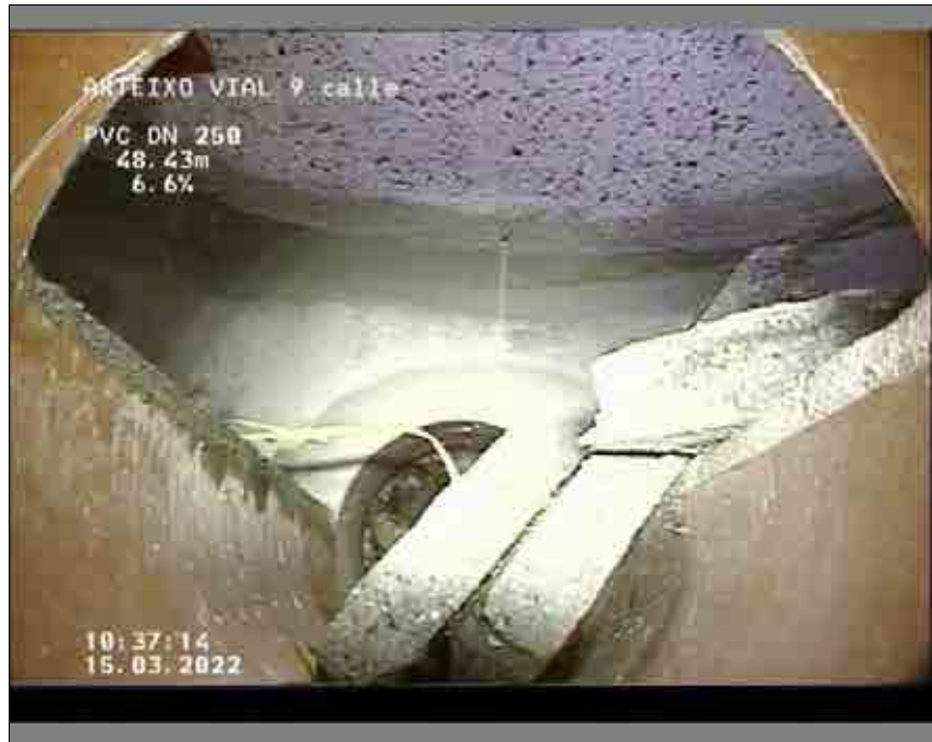
Foto: 1_1_3_A.JPG 48,43m, Fin de la inspección P1
