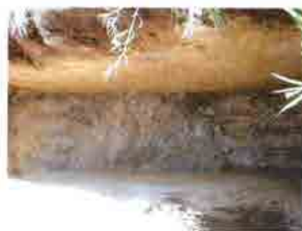
Fotografía 26. Vista de las paredes de la calicata C-9.
