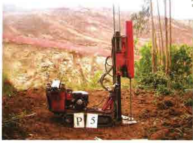
Fotografía 3. Situación del ensayo de penetración dinámica superpesada P-5.
