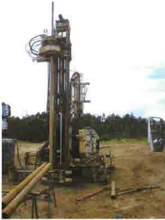
Fotografía 1 Sonda perforadora Tecónse TP50-D en el emplazamiento S-2.
