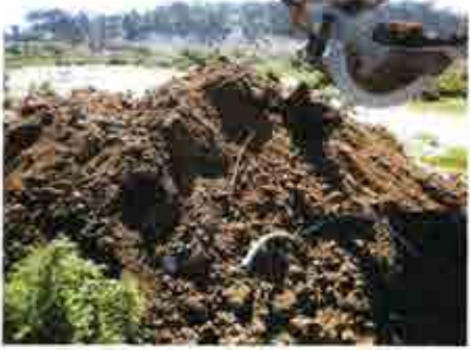
Fotografía 6. Vista de los materiales extraídos de la calicata C-2.
