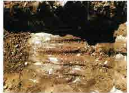
Fotografía 14. Vista de las paredes de la calicata C-5.
