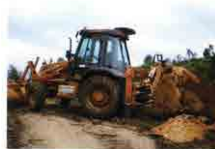
Fotografía 37. Pala mixta en el emplazamiento de la calcata C-13.
