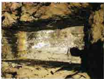
Fotografía 23. Vista de las paredes de la calicata C-8.
