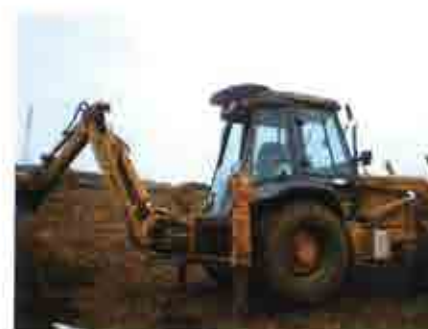
Fotografía 31 Pala mixta en el emplazamiento de la calcata C-11.
