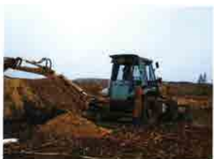
Fotografía 34. Pala mixta en el emplazamiento de la calcata C-12.
