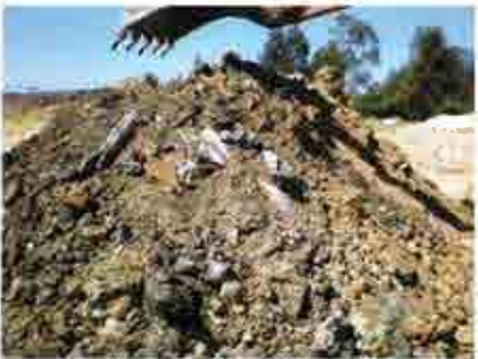
Fotografía 12. Vista de los materiales extraídos de la calicata C-4.
