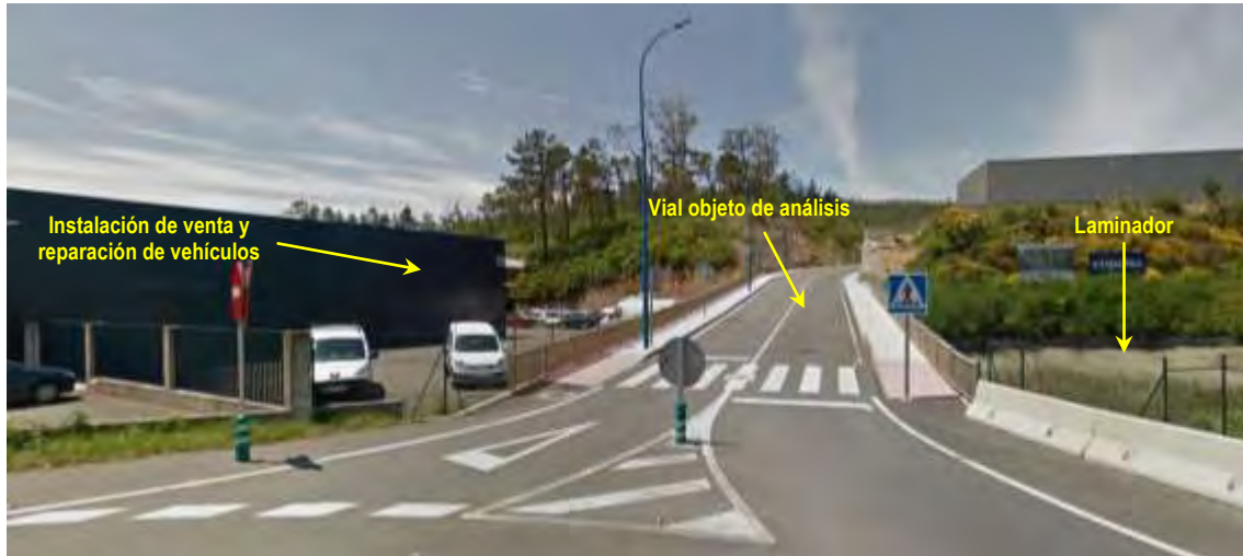
Vista general del vial ejecutado
