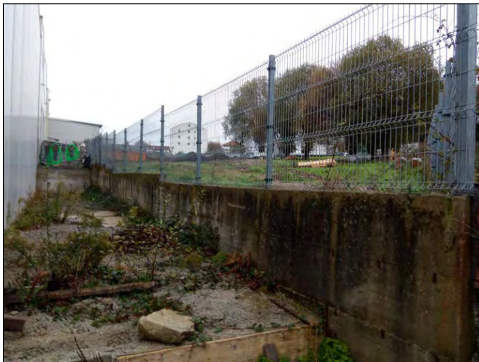
Fotografía 4: Vista general de la zona de actuación desde la zona sur.
