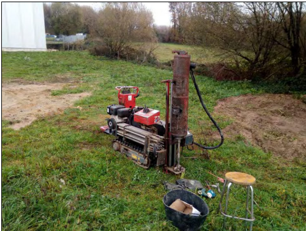
Fotografía 21: Ensayo de penetración PD-1.
