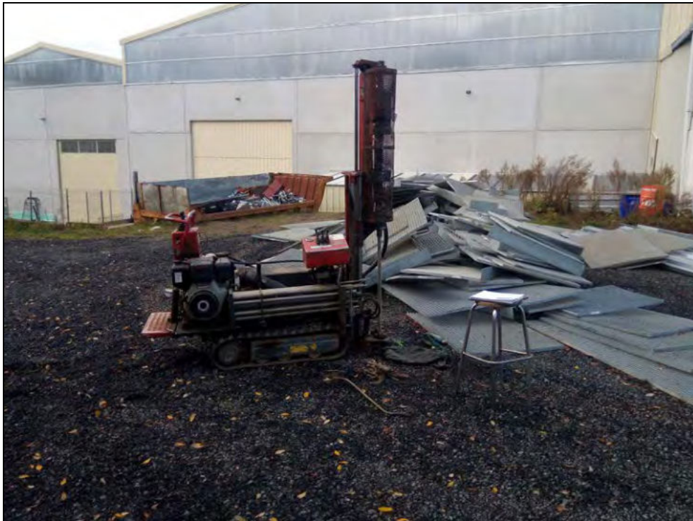
Fotografía 23: Ensayo de penetración PD-3.
