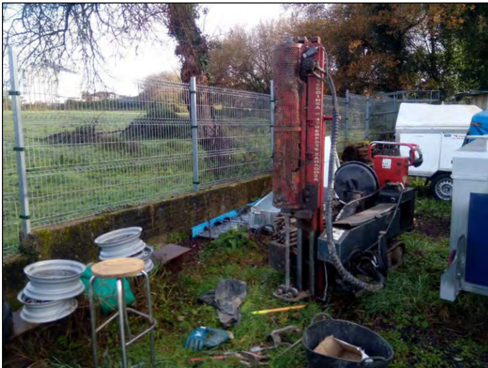
Fotografía 25: Ensayo de penetración PD-5.
