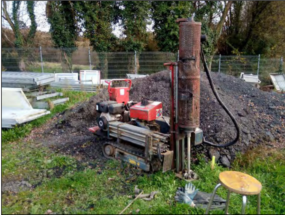
Fotografía 24: Ensayo de penetración PD-4.
