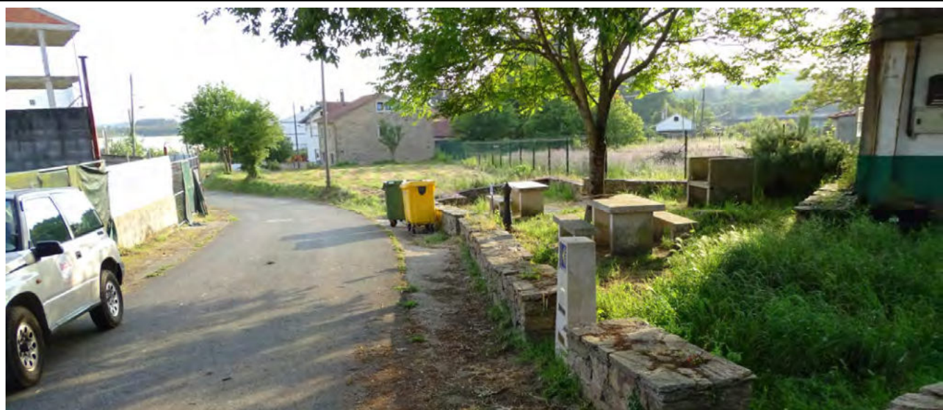
C.8: Indicador de distancia e área de descanso na marxe dereita do Camiño, con edificacións que empezan a amosar caracteres urbanos (edificio á esquerda da imaxe). A vista está tomada dende N
