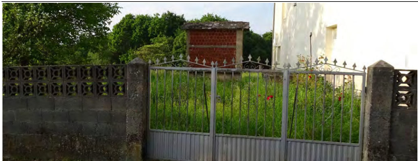
Hórreo 1: pequena construción en cemento e ladrillo a carón do lateral O da vivenda. Vista tomada dende S
