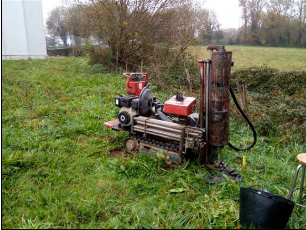
Fotografía 22: Ensayo de penetración PD-2.
