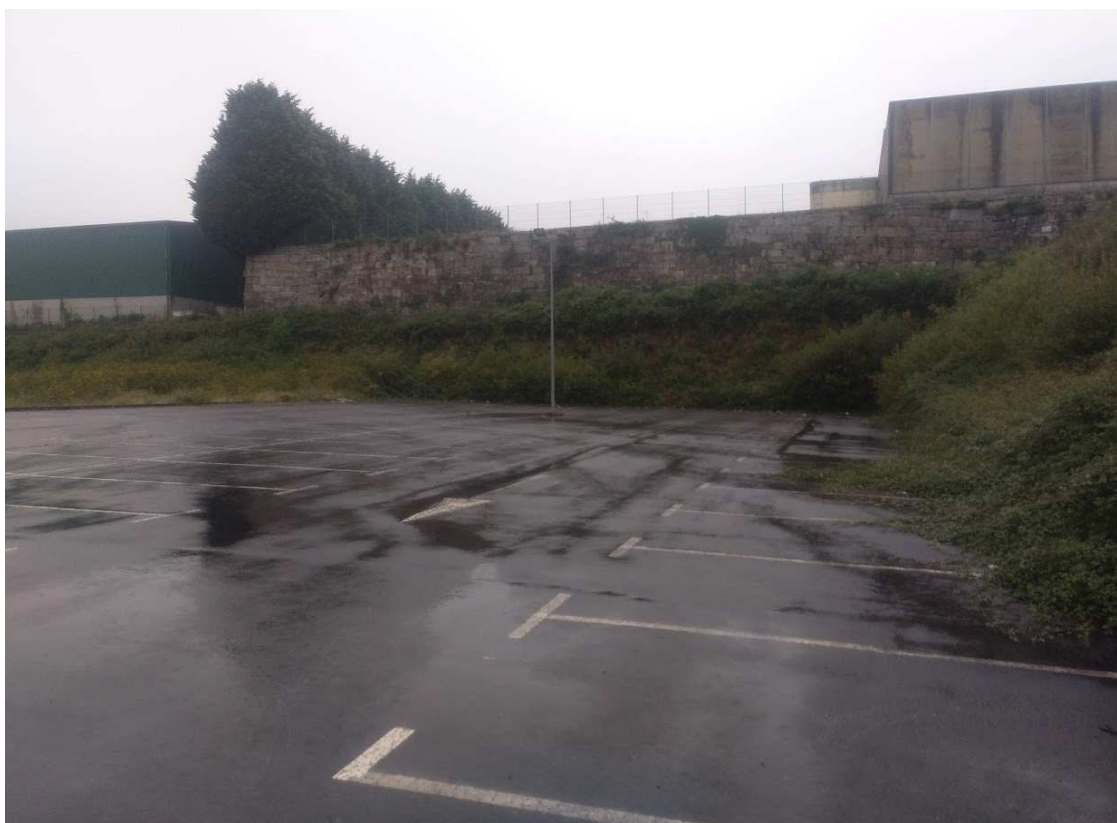
Zona de aparcamento na plataforma superior (27/06/2020)
