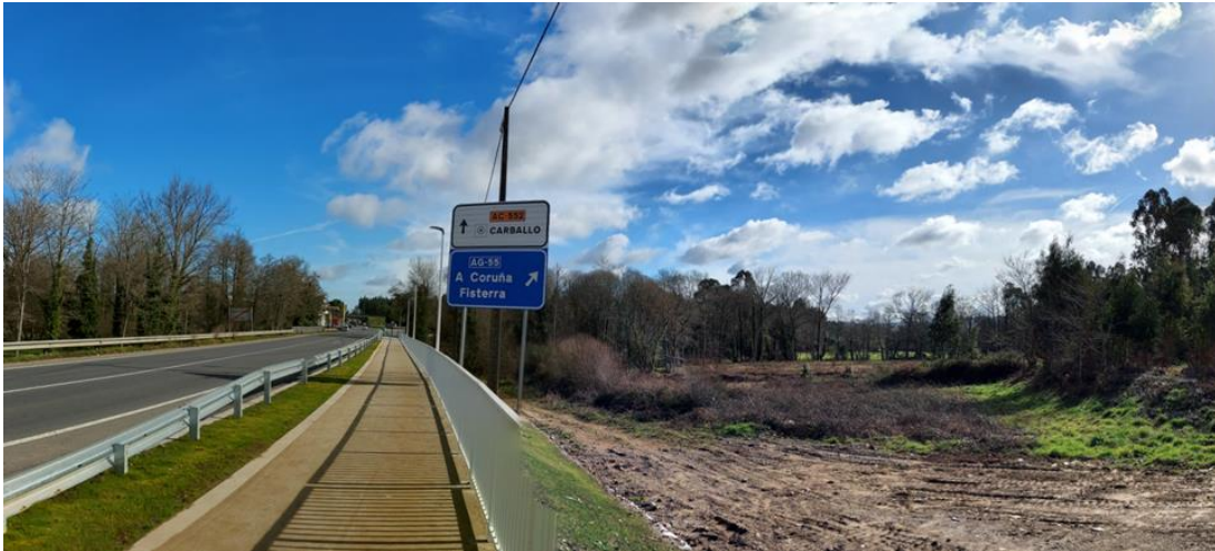
Foto 07: carretera AC-552, al norte del ámbito de actuación
