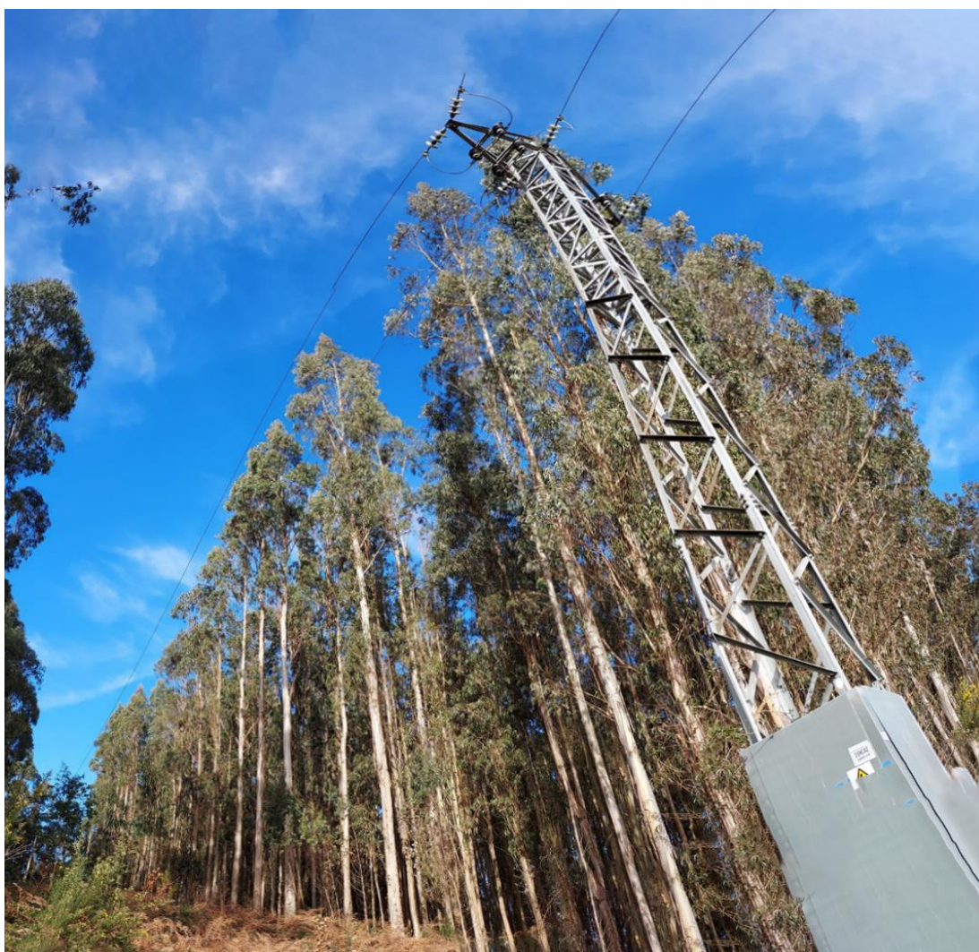
Foto 05- LAT aérea que atraviesa el ámbito
