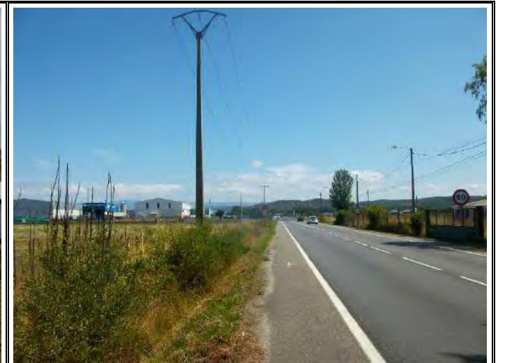
FOTO Nº04: Torre de Alta Tensión existente en el frente del Polígono 2 cuya línea aérea se tendrá que pasar a subterránea
