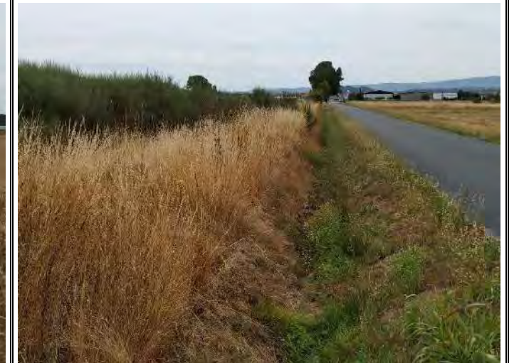
FOTO Nº20: Vista del cunetón-canal que discurre por el lateral del Polígono 2 donde desaguaran las aguas pluviales
