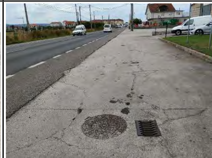
FOTO Nº23: Zona por donde discurrirá la impulsión del bombeo de la red de saneamiento del Polígono 2
