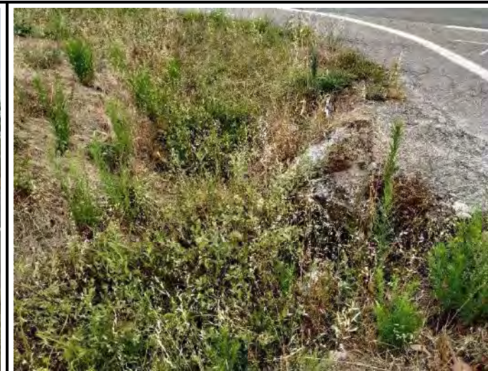
FOTO Nº15: Vista de la obra de drenaje actual ODT de cruce con viales
