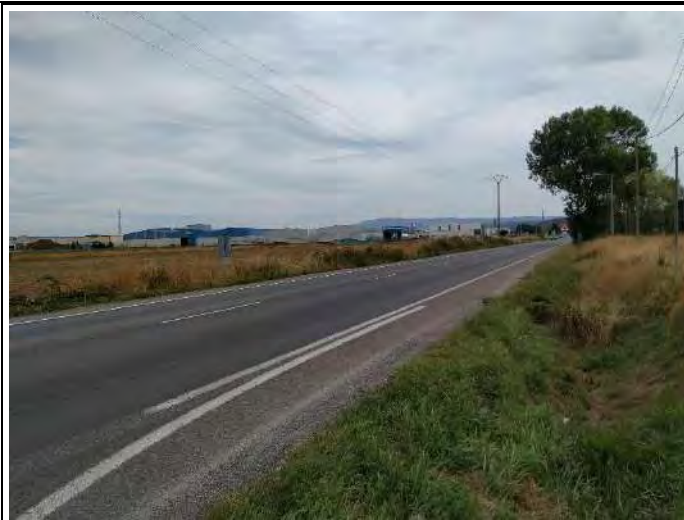
FOTO Nº13: Vista del frente del Polígono 2 donde se ubicará la nueva glorieta de conexión con la carretera general
