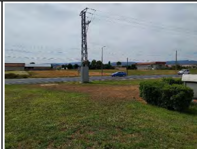
FOTO Nº03: Torre de Alta Tensión donde se encuentra el actual paso de la línea aérea a subterránea
