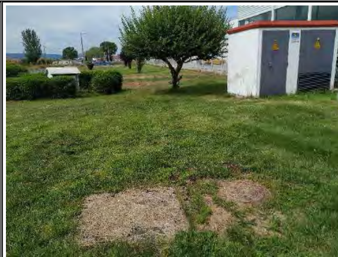
FOTO Nº02: Zona donde se conectará con los servicios existentes (eléctricos, abastecimiento, telecomunicaciones...)
