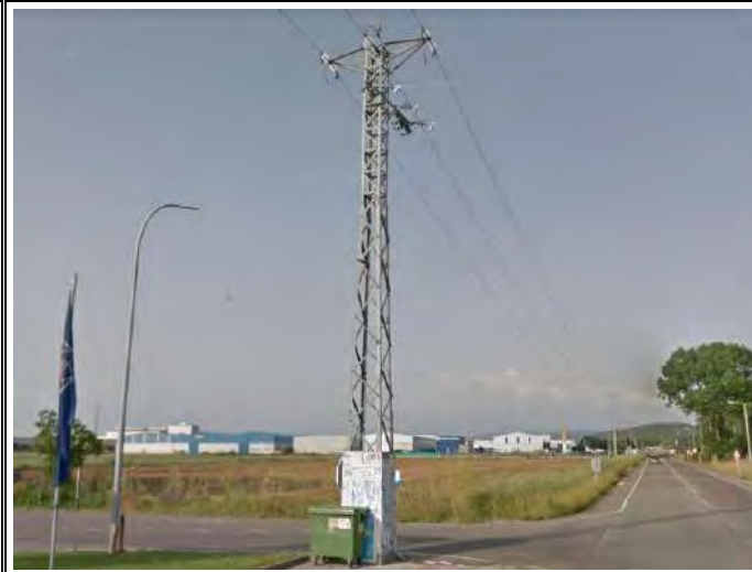
FOTO Nº06: Torre de Alta Tensión hasta donde se tendrá que enterrar la actual línea aérea (paso de aérea a subterránea)
