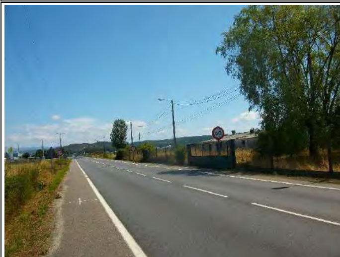
FOTO Nº09: Zona donde se ubicará la nueva glorieta de conexión del Polígono 2 con la carretera general
