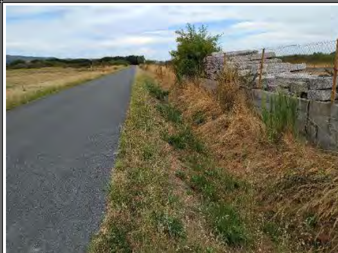
FOTO Nº22: Vista del cunetón-canal que discurre por el lateral del Polígono 2 donde desaguaran las aguas pluviales
