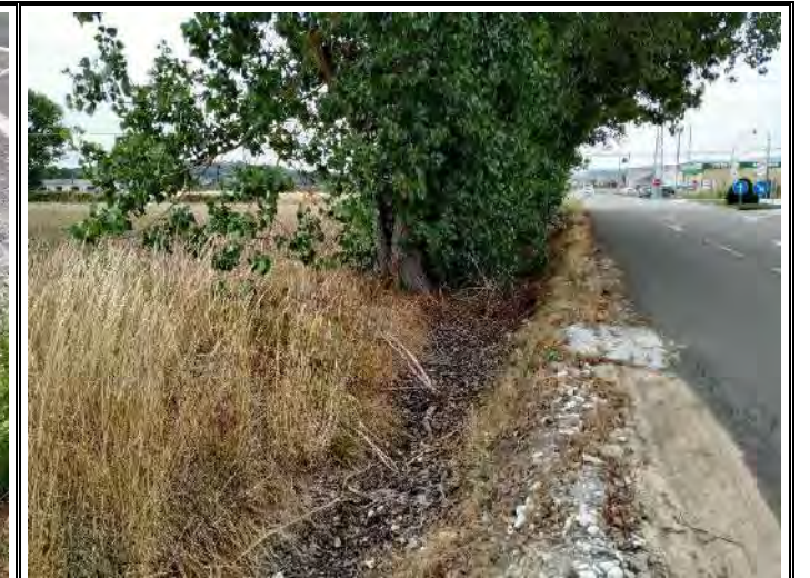
FOTO Nº16: Vista del cunetón-canal que discurre por el lateral del Polígono 2 donde desaguaran las aguas pluviales
