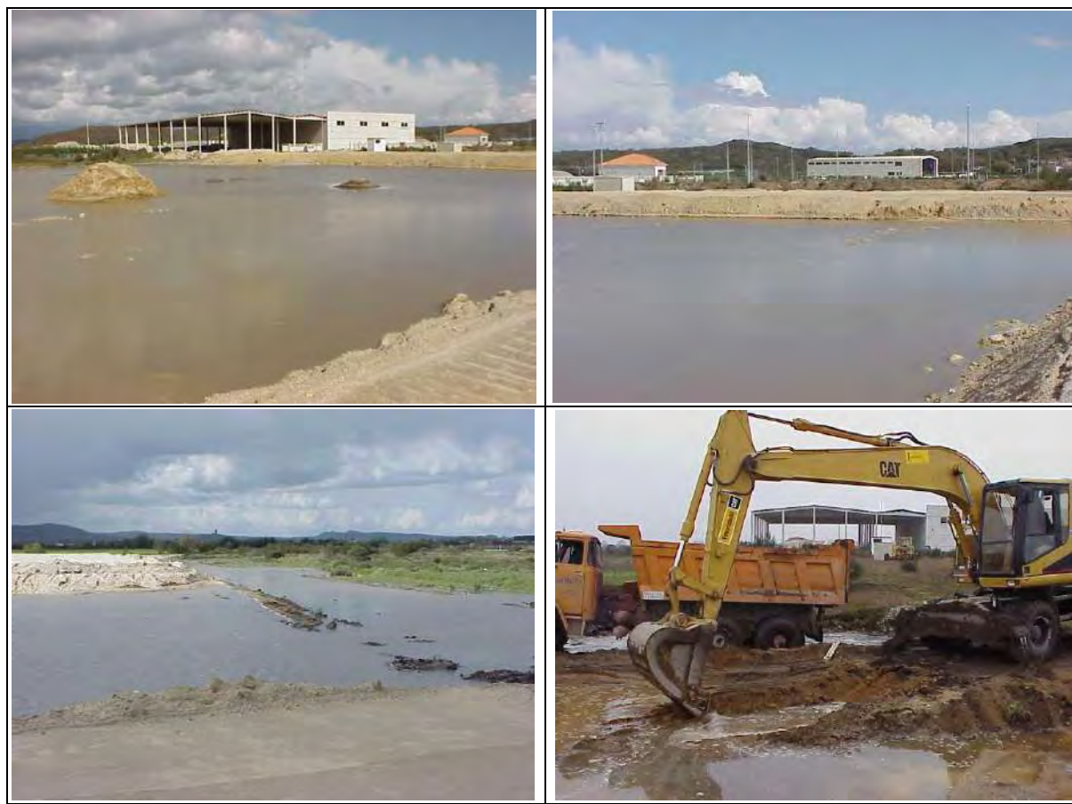
Imágenes de los terrenos anegados durante la construcción de la Fábrica de Vidrio en el PE de Xinzo de Limia
