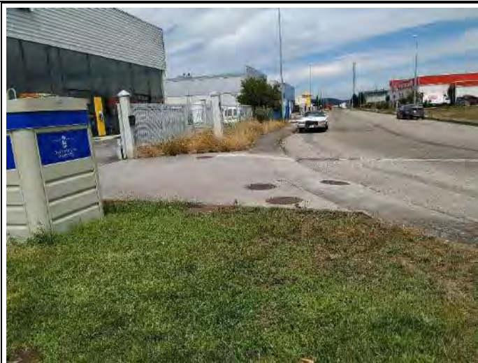
FOTO Nº01: Vista del Sector del PE Xinzó construido
